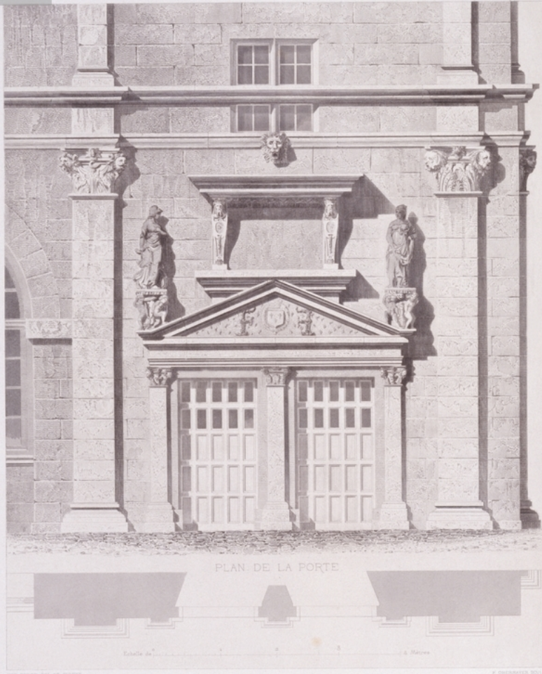
COUR OVALE PORTE DE LA TOUR PRES LA PORTE DOREE
